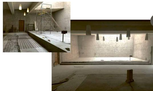
**1** En réflexion depuis plusieurs années, les travaux de transformation de la chapelle ont débuté ! En septembre, les maçons ont retiré les bancs de béton, réduit la hauteur des marches, agrandi le parvis, et coulé une dalle homogène sur l'ensemble du sol.
