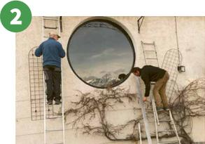
**2** Brise-soleil orientables installés en salle Vercors, pose d'auvents et végétalisation de la façade des hublots : pour garder la fraîcheur.
